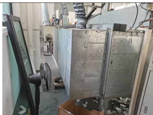
泡沫电热分切机“侧式集气罩”
