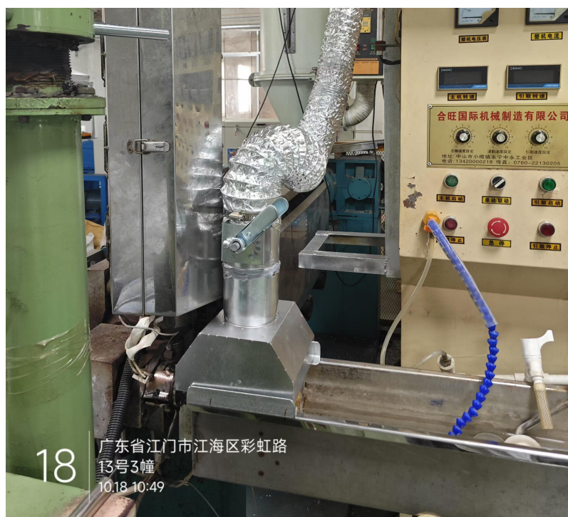
图 4-1 集气罩示意图
